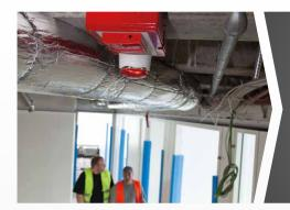
Das erste drahtlose und mobile Brandmelde- und Evakuierungssystem, das nach der europäischen Norm EN 54 entwickelt wurde.
